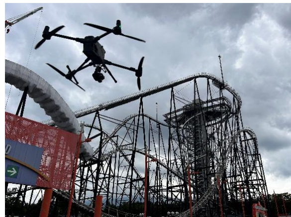
※ドローン点検の様子
