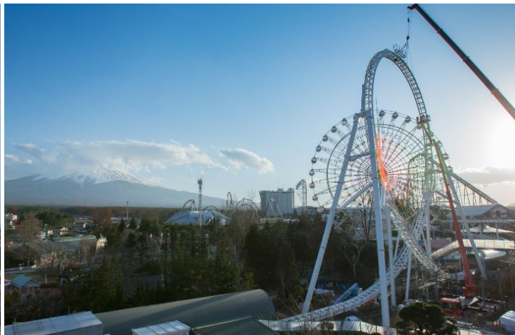
現在「ループ」建設中の「ド・ドンパ」
