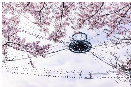
絶叫吊り橋「風天」
