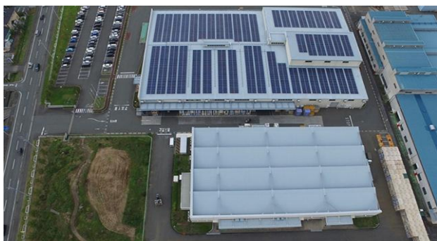
当社浜松事業所全景。 富士エコサイクルの屋根に設置された 太陽光パネル(写真上部)。
