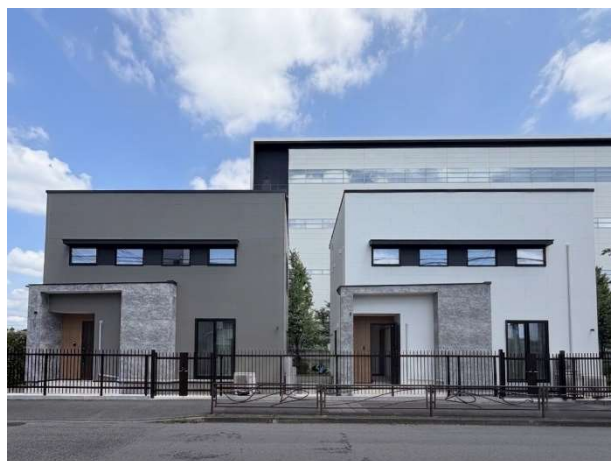
ゼネラル川崎本社敷地内に建設した実証実験住宅 2 棟
