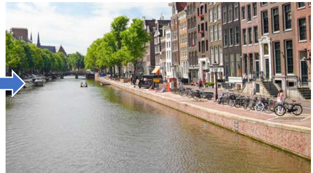
パイロット施工後
