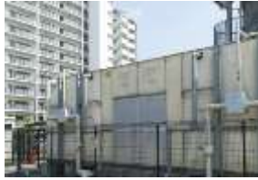
■タンク内の残量監視
