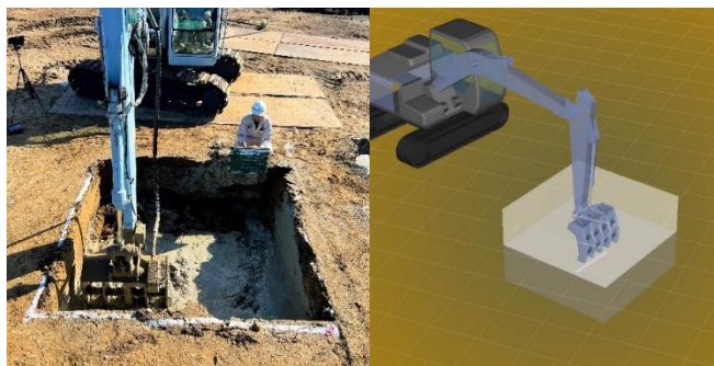
施工状況と管理画面での三次元計測モデル表示
