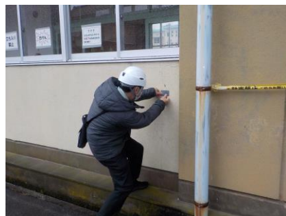
屋外点検の様子
