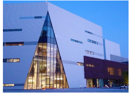
箕面市立船場生涯学習センター 建物外観
