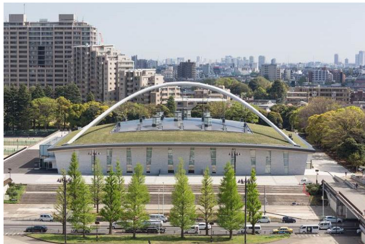
屋内球技場 外観
