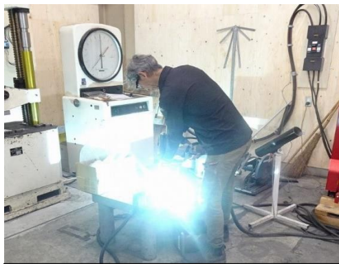
スタッド溶接の様子
