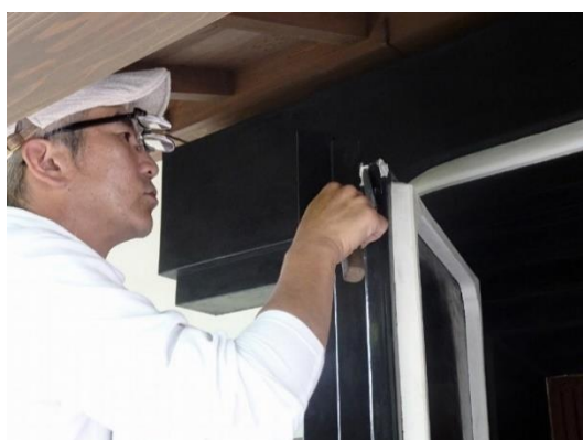
土蔵の修復（蔵戸前）の様子
