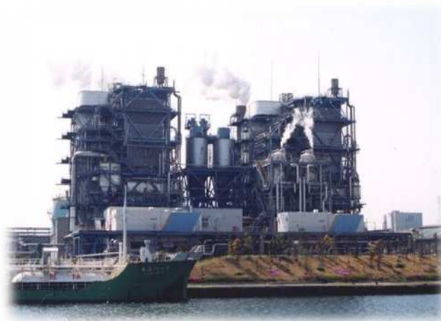
川崎事業所の自家発電設備（現在）
