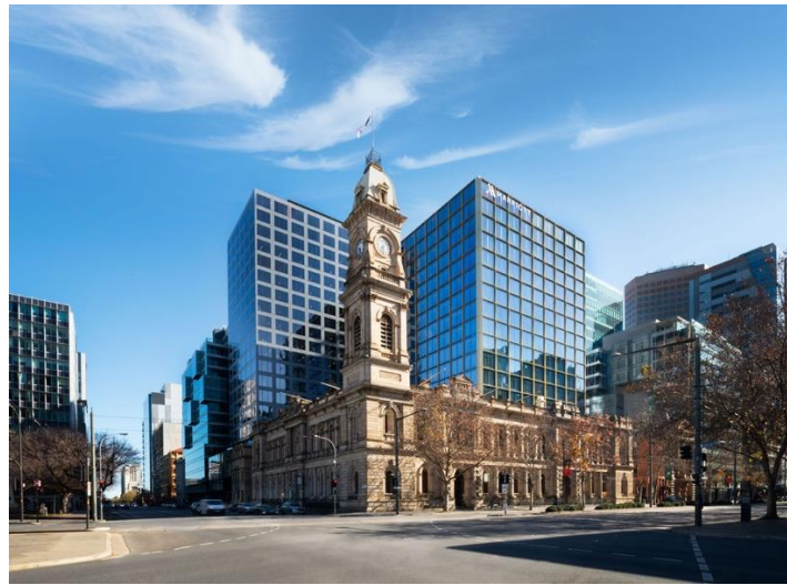
アデレード・マリオット・ホテル外観
