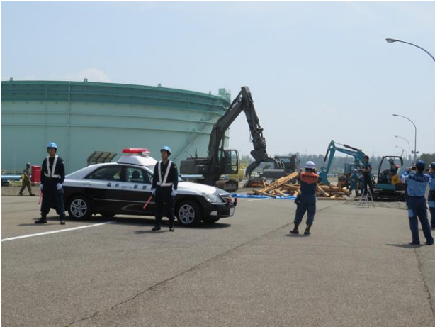
陸上自衛隊重機等による道路障害物撤去
