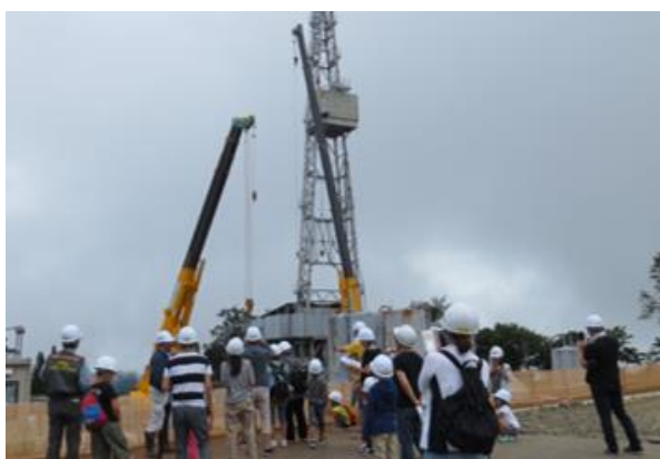
湯沢市地熱見学会の山葵沢地熱発電所建設地点訪問 (8月19日)
