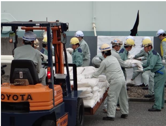
防油堤亀裂箇所への土のう構築
