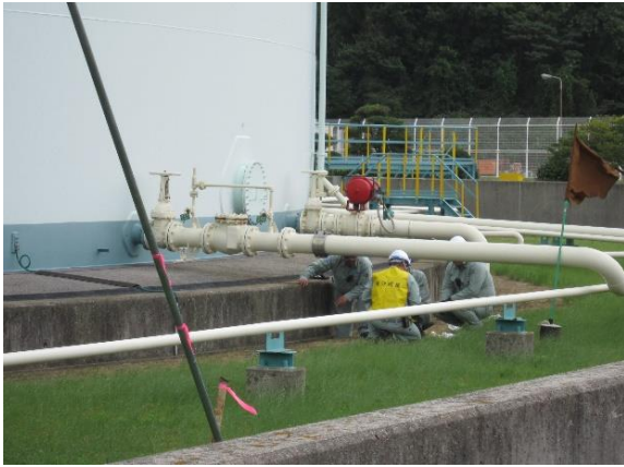
原油漏洩箇所の応急処置
