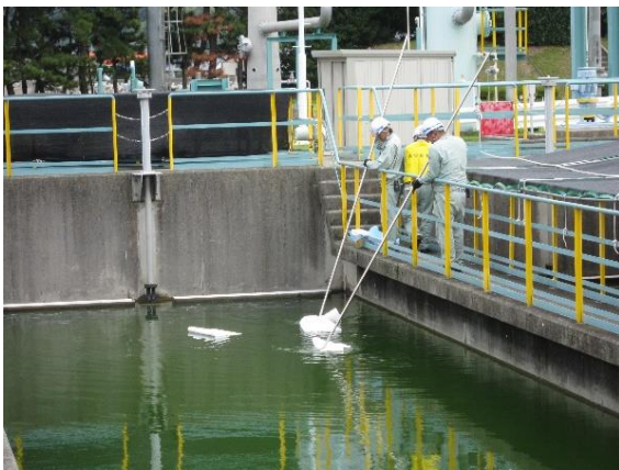
ガードベースンでの流出油の回収
