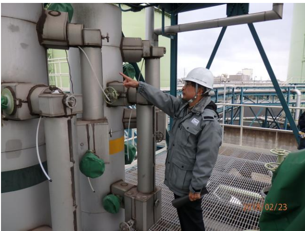
配管満液確認
