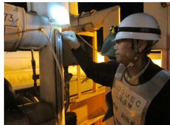
満液状態確認作業
