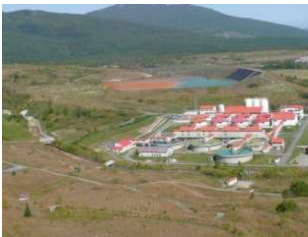
旧松尾鉱山新中和処理施設
