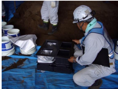
土のう製作機使用状況①
