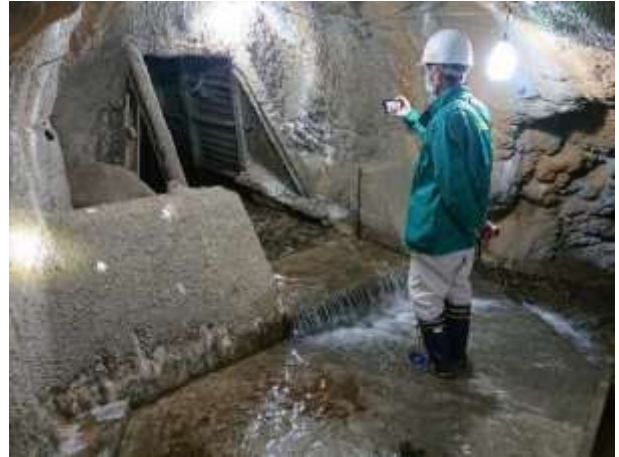
現地見学会(右奥坑道手前, 整備終点)
