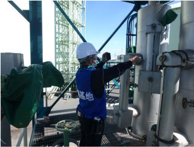
数量確認作業(配管内満液確認)
