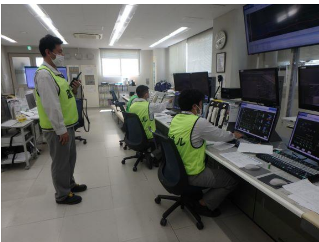
中央計器室での放出操作・監視状況
