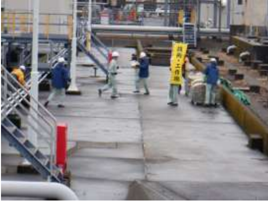
自衛防災隊(技術・工作班)による漏油拡散防止の土のう構築
