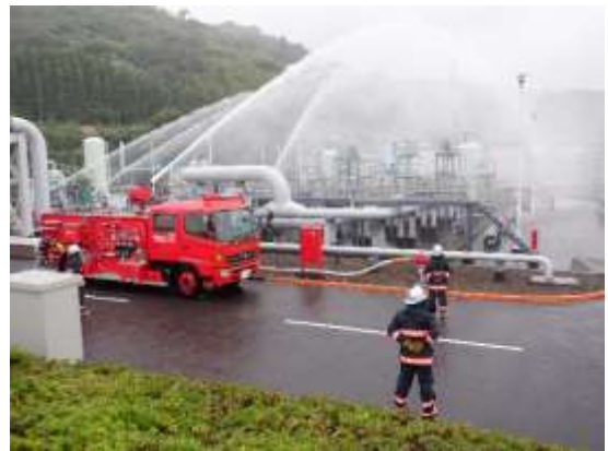
消防車による一斉放水
