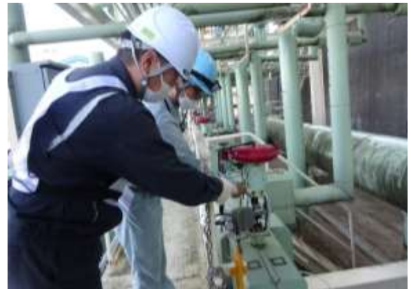
配管の満液確認
