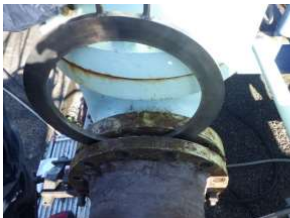
配管仕切板の開放
