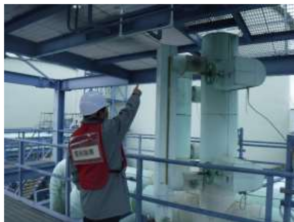
配管満液確認
