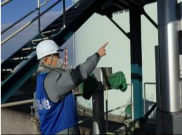
数量確認作業(配管内満液確認)
