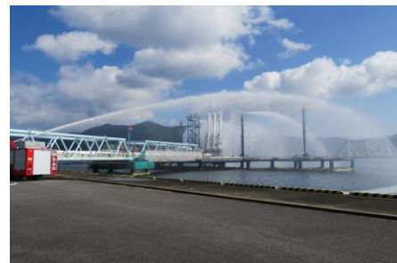
一斉放水(消防車、シーバース)
