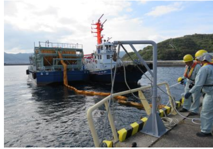
一次オイルフェンス展張600m
