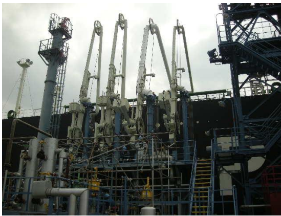
棧橋接続状況
