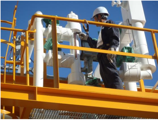
数量確認作業(配管内満液状態確認)
