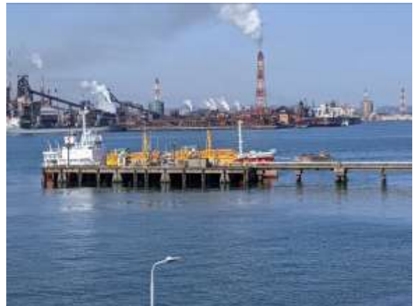
石油ガス受入中の内航船
