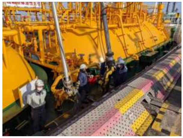
ローディングアーム接続作業
