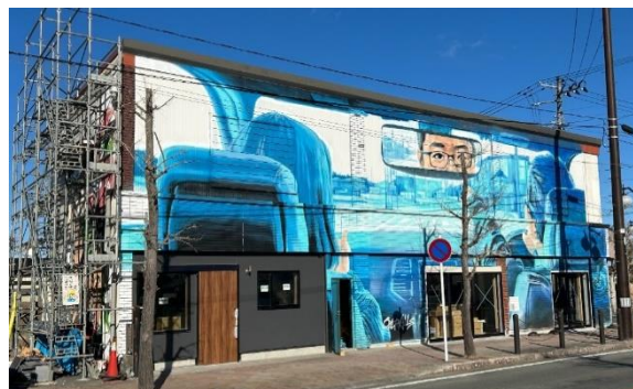
現在の様子（工事中）
