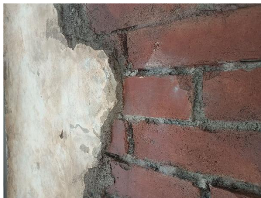
レンガもすべてモルタルアート
