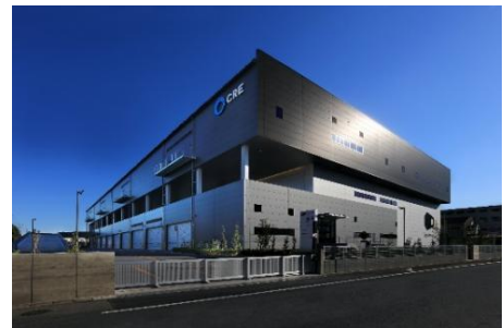
22 ロジスクエア白井 2022年12月竣工
