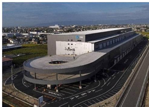
26 ロジスクエア一宮 2023年9月竣工
