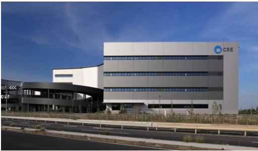
33 ロジスクエアふじみ野 B 2024年10月竣工
