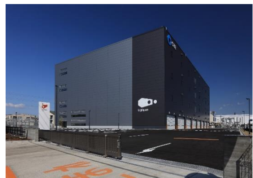
24 ロジスクエア厚木 I 2023年3月竣工
