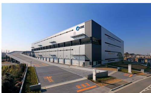
7 ロジスクエア浦和美園 2017年4月竣工
