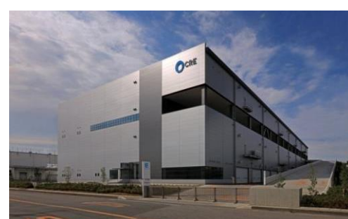
4 ロジスクエア久喜 2016年6月竣工
