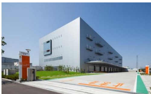
1 ロジスクエア草加 2013年6月竣工
