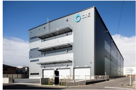
34 ロジスクエア草加Ⅱ 2024年10月竣工
