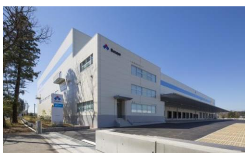
3 ロジスクエア日高 2015年3月竣工
