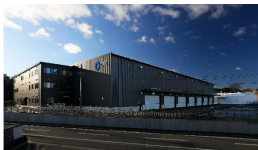
28 ロジスクエア掛川 2024年1月竣工
