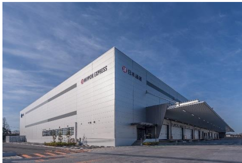
11 ロジスクエア鳥栖 2018年2月竣工
