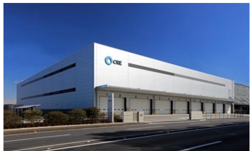
6 ロジスクエア久喜Ⅱ 2017年2月竣工
