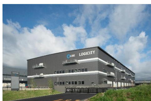
32 ロジシティ小郡 2024 年 7 月竣工
