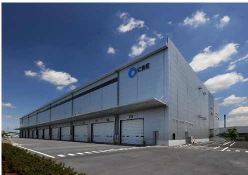
15 ロジスクエア川越Ⅱ 2019 年 6 月竣工
