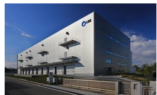
8 ロジスクエア新座 2017年4月竣工
