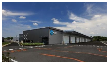
31 ロジスクエア成田 2024 年 5 月竣工
