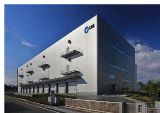
8 ロジスクエア新座 2017 年 4 月竣工
