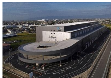
26 ロジスクエアアノ宮 2023 年 9 月竣工
