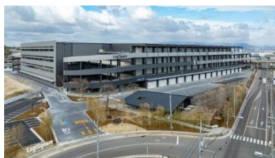
35 ロジスクエア京田辺 A 2025 年 2 月竣工
