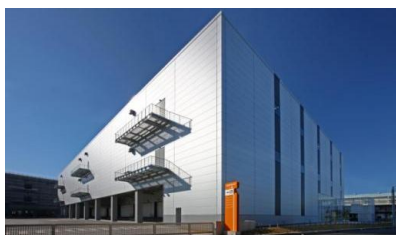
2 ロジスクエア八潮 2014年1月竣工
