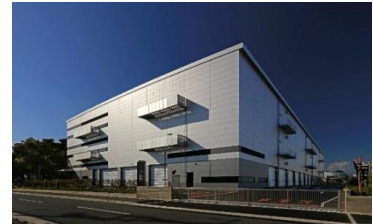
21 ロジスクエア伊丹 2022年11月竣工
