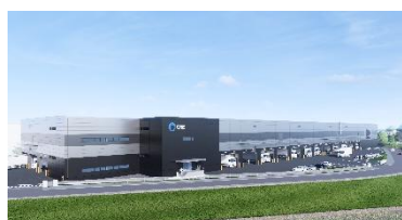
8 ロジスクエア鳥栖Ⅲ 2027 年 4 月竣工予定
