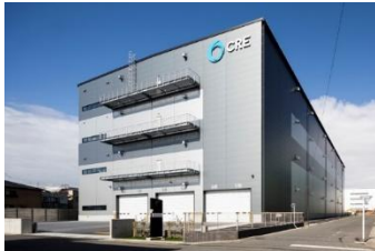
34 ロジスクエア草加Ⅱ 2024年10月竣工
