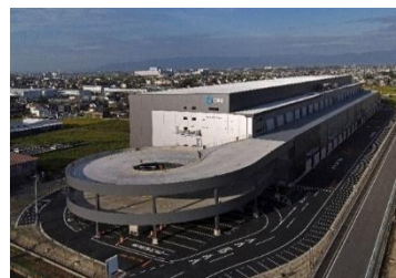
26 ロジスクエアアノ宮 2023 年 9 月竣工
