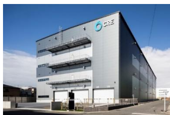
34 ロジスクエア草加Ⅱ 2024 年 10 月竣工
