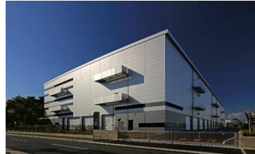
21 ロジスクエア伊丹 2022 年 11 月竣工
