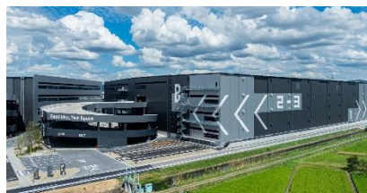
38 ロジスクエア京田辺 B 2026 年 8 月竣工
