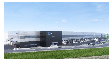
7 ロジスクエア鳥栖Ⅲ 2027 年 4 月竣工予定
