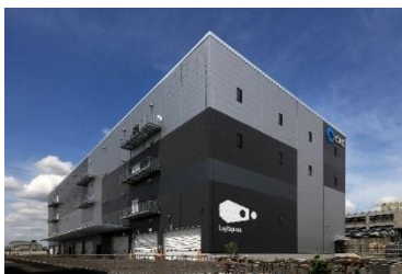
25 ロジスクエア松戸 2023 年 5 月竣工
