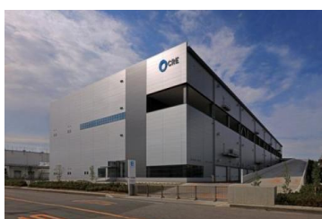
4 ロジスクエア久喜 2016 年 6 月竣工
