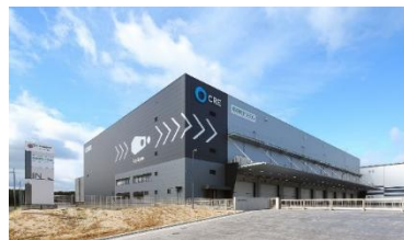
29 ロジスクエア福岡小郡 2024 年 2 月竣工
