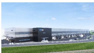
6 ロジスクエア鳥栖Ⅲ 2027 年 4 月竣工予定
