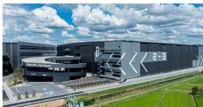
38 ロジスクエア京田辺 B 2026 年 8 月竣工
