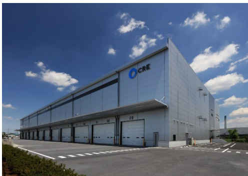
15 ロジスクエア川越Ⅱ 2019年6月竣工
