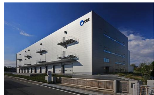
8 ロジスクエア新座 2017年4月竣工
