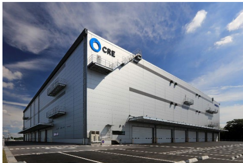
13 ロジスクエア春日部 2018年6月竣工
