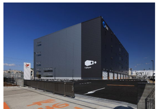
24 ロジスクエア厚木 I 2023年3月竣工
