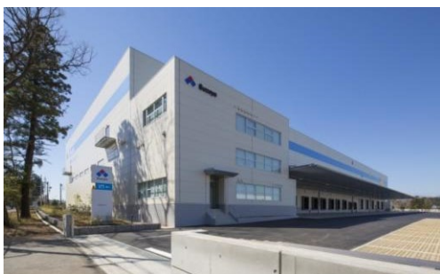
3 ロジスクエア日高 2015年3月竣工
