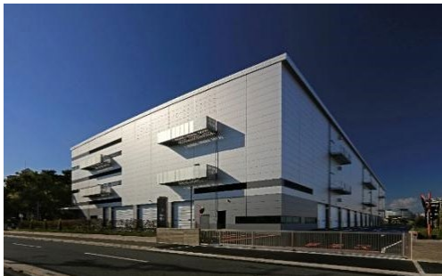
21 ロジスクエア伊丹 2022年11月竣工
