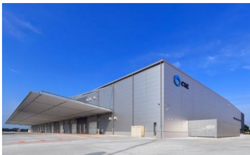
5 ロジスクエア羽生 2016年7月竣工
