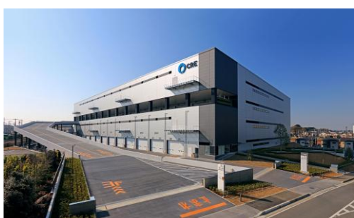
7 ロジスクエア浦和美園 2017年4月竣工
