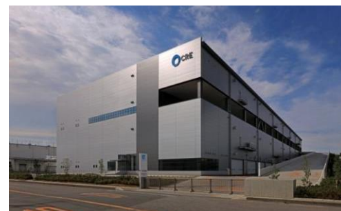
4 ロジスクエア久喜 2016年6月竣工
