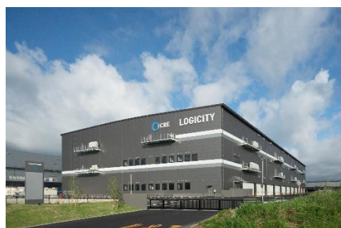
32 ロジシティ小郡 2024年7月竣工
