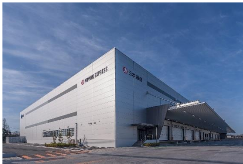
11 ロジスクエア鳥栖 2018年2月竣工
