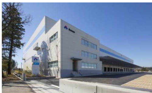
3 ロジスクエア日高 2015年3月竣工
