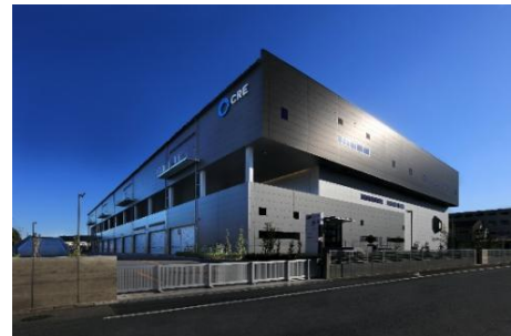
22 ロジスクエア白井 2022年12月竣工
