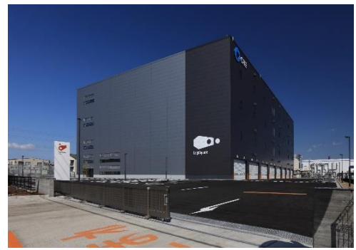
24 ロジスクエア厚木 I 2023年3月竣工
