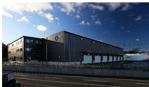
28 ロジスクエア掛川 2024年1月竣工
