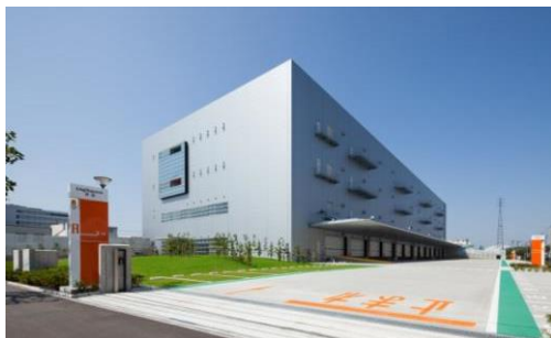
1 ロジスクエア草加 2013年6月竣工
