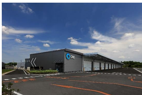
31 ロジスクエア成田 2024年5月竣工
