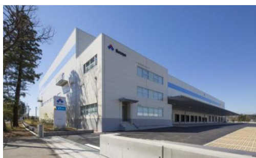
3 ロジスクエア日高 2015年3月竣工
