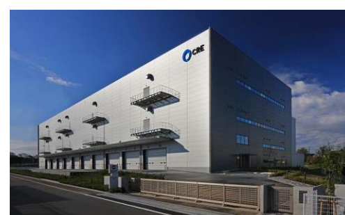
8 ロジスクエア新座 2017年4月竣工
