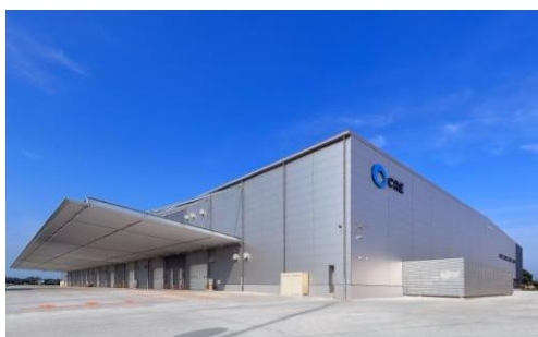
5 ロジスクエア羽生 2016年7月竣工
