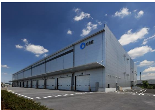
15 ロジスクエア川越Ⅱ 2019年6月竣工
