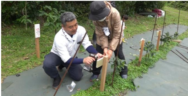
▲看板を取り付けている様子
