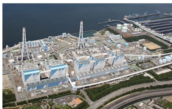
碧南火力発電所（愛知県碧南市）
