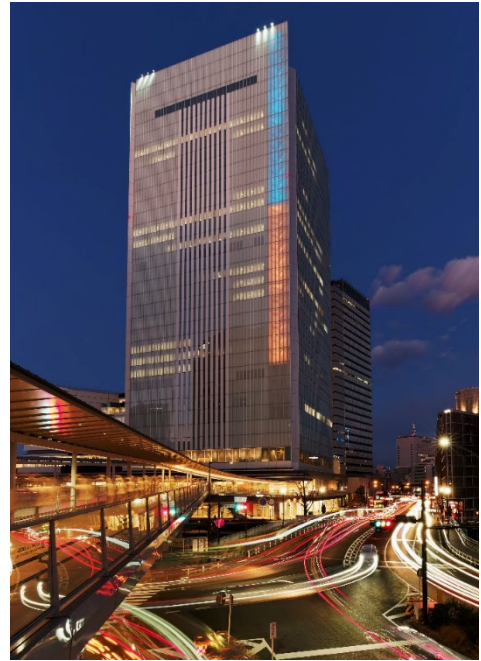
建 物 名：横浜市役所 タイトル：「願いを込めて」 受 賞 者：@kdo.yokohama2
