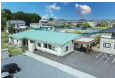
小規模多機能型居宅介護 チューリップみさと 美里町
