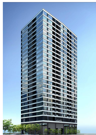
▲建替え後、外観完成予想CG ※今後の諸官庁協議・合意形成・経済情勢等により変更となる場合があります。
