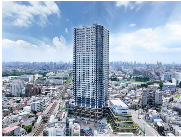
本建物外観(全景)
