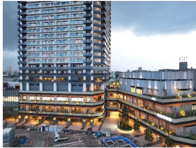
本建物外観(基壇部)
