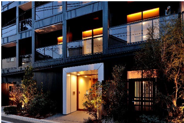
▲エントランス（外観）
